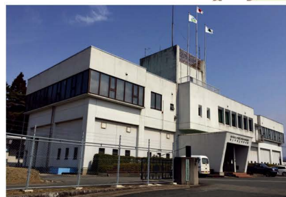
北上川浄水場 (昭和53年供用開始)
