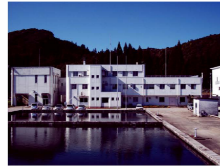
◀管理棟、脱水機棟
