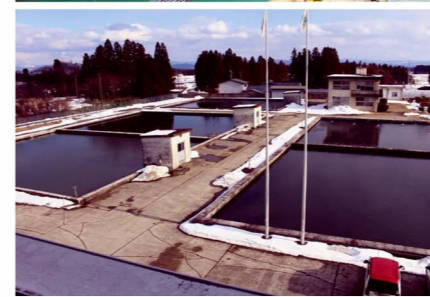
◀緩速ろ過池 1日4~5mの速さでゆっくり砂ろ過します。
