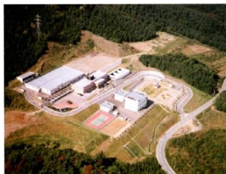
岩手中部浄水場
