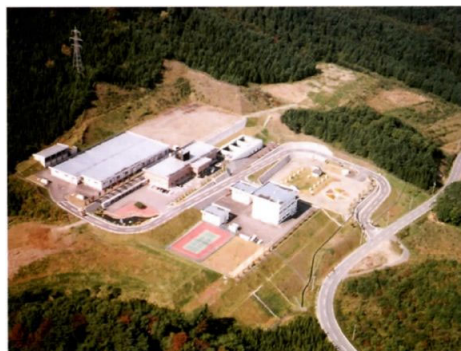
岩手中部浄水場
