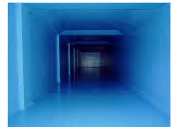
古館城山配水池(内部)
