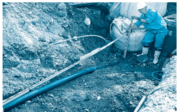
80cmの地盤隆起にも耐えた HPPE 提供：配水用ポリエチレンパイプシステム協会
