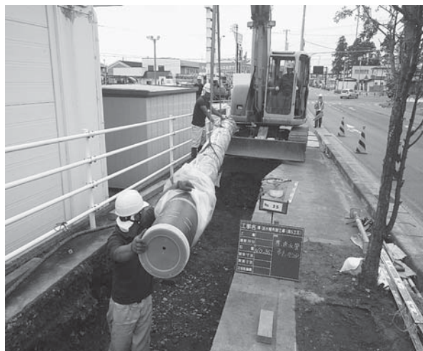
耐震管の布設工事
