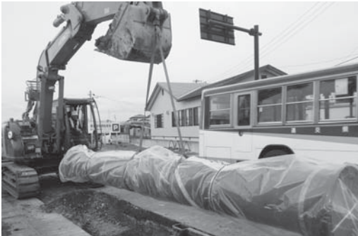
(県立中部病院付近) 送水管布設工事
