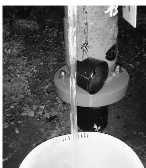
消火栓から濁水を排水する様子
