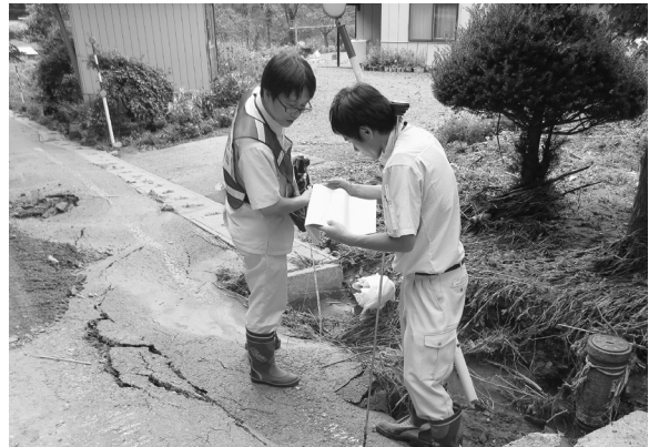
現地施設調査
