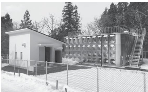
整備された土沢配水池 (花巻市)
