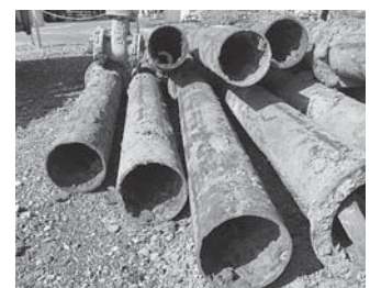
掘り上げた古い水道管 (昭和44年布設)
