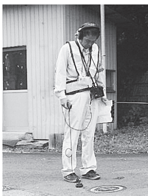
路面音聴作業の様子
