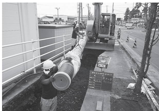
耐震管の布設工事
