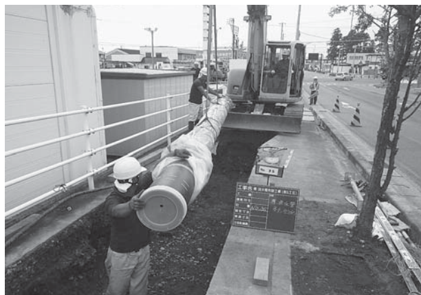
耐震管の布設工事
