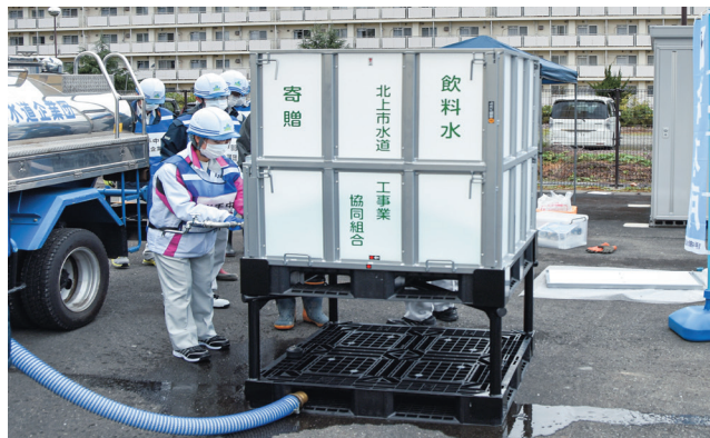
給水タンクの組み立ての様子
