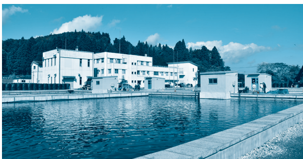
更新された高円万寺浄水場緩速ろ過池 (花巻市)
