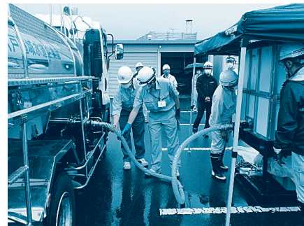
給水車から仮設給水タンクへポンプ圧送を行う八戸圏域水道企業団職員
