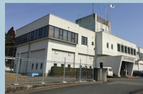
北上川浄水場
