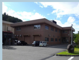
岩手中部浄水場
