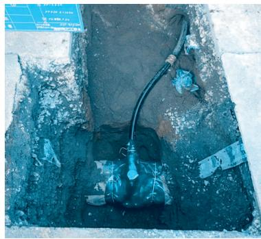
新しい水道管と給水管を繋ぎ合わせます。繋ぎ合わせた部分はフィルムを巻いて、腐食から保護します。
