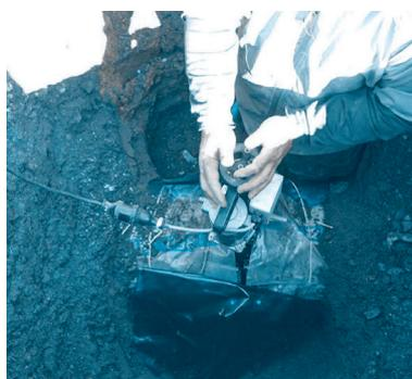
給水管を繋ぐため、新しい水道管に穴を開けます。
