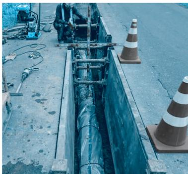
新しい水道管を設置している様子。ダクタイル鋳鉄管と呼ばれる耐震性に優れた管を設置しています。
