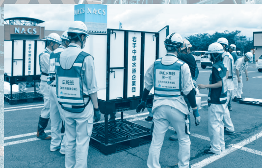
給水タンクを組み立てる企業団職員
