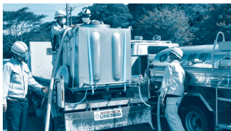
給水車から給水タンクに給水する様子
