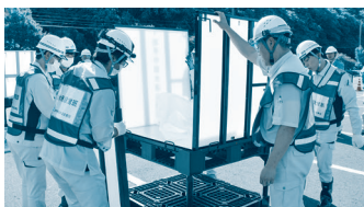
給水タンクを組み立てる職員
